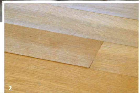
1 – 2 Auf Aus- und Einbaukosten von 30 000 Euro blieb ein Bodenleger sitzen, der mangelbehaftete Parkettziele austauschen musste – die Decklamellen waren nicht einwandfrei verklebt
